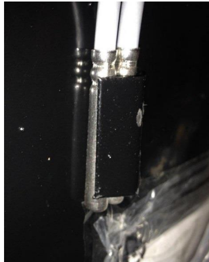
Fixation de 2 sondes, plaquette frappée au marteau
