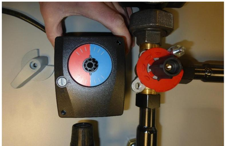
Débrayer le moteur de vanne en position manuelle à l'aide d'un tournevis plat (appuyer et tourner sans forcer)
